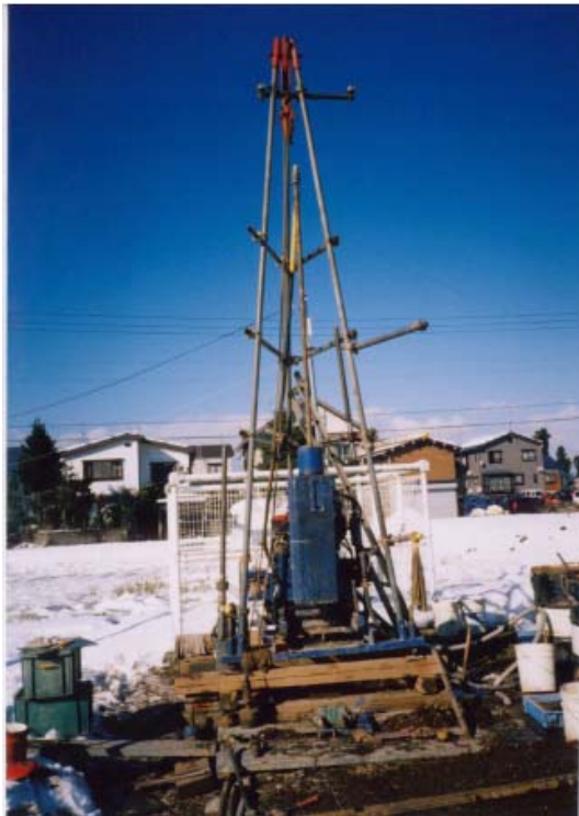
写真 2.3.1 (1) ボーリング・PS 検層の実施状況 (K-NET)
