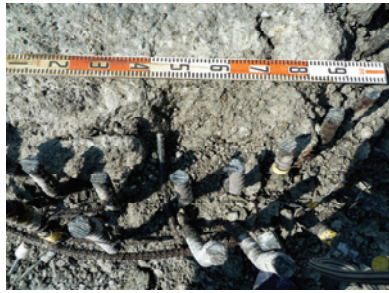
写真-6 帯鉄筋の定着部 (SW面)
