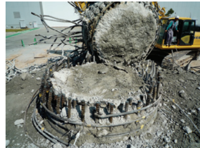
写真-5 破壊面
