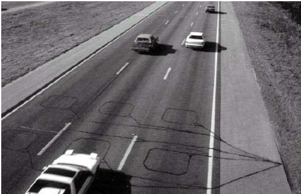
Figure 2.2: Double loop detector (Klein, 2003).
