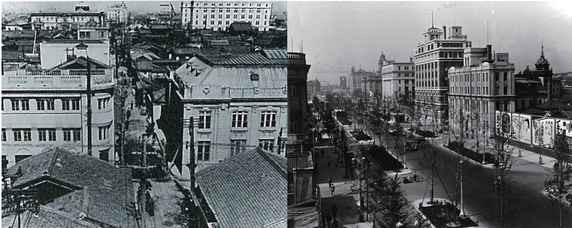
写真11 御堂筋街路建設前後の同街路沿道(付録1中Aの地点付近、左図:建設前、右図:建設後) (左図:『大阪市制100周年記念写真で見る大阪市100年』、大阪都市協会、1989より引用) (右図:大阪市による写真提供)
