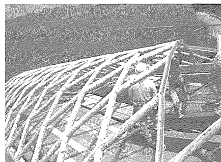
●「ところミュージアム大三島」(2004) 施工中の写真
