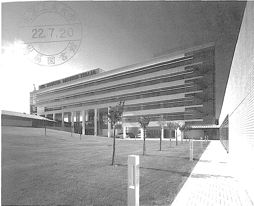
図1 トヨタモーターイタリア新社屋 オフィス南側ファサード 水平ラインの強調 — 透明感を保ちながら高断熱性能を実現したファサード
