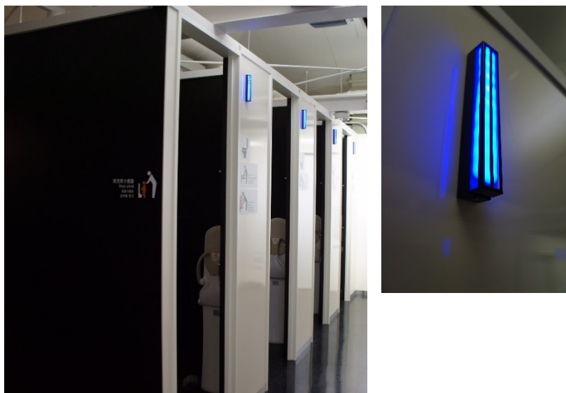
図 1-8 利用中ランプの設置状況（愛鷹 PA 上り線）
