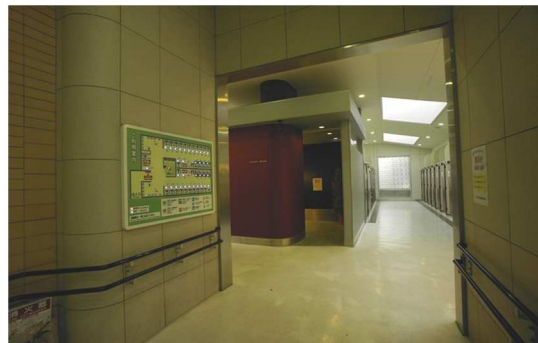
図 3-11 中井 PA 下における利用案内表示板の設置状況
