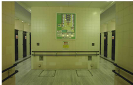
図 3-10 中井 PA 上における利用案内表示板の設置状況
