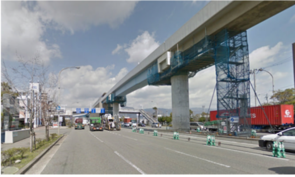
図2.2 新交通システムの高架橋の例
