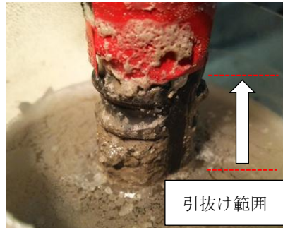
写真4 引抜け破壊(S2)
