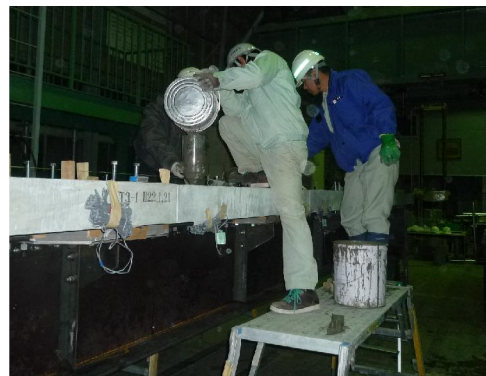
(d) Filling mortar
