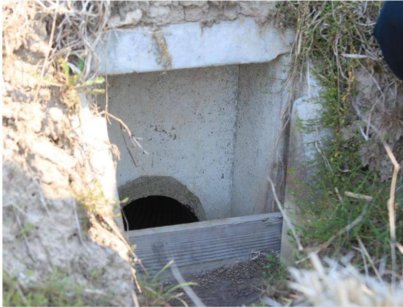
写真 2-3 排水口の仕組み
