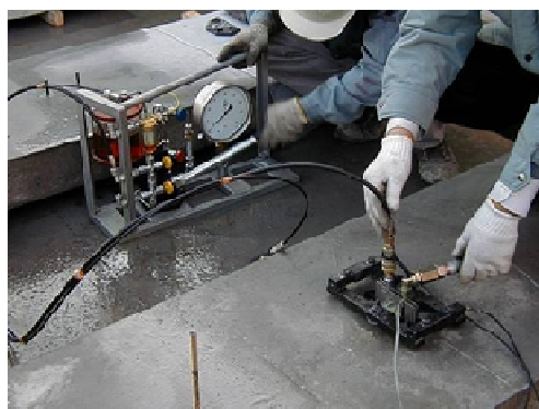
写真 1.2.6 フラットジャッキによる加圧状況
