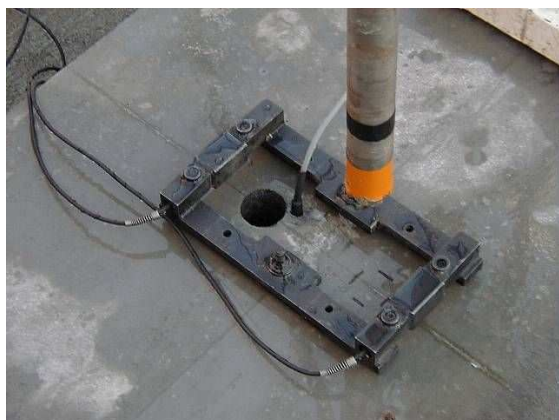
写真 1.2.3 片側のコア削孔完了
