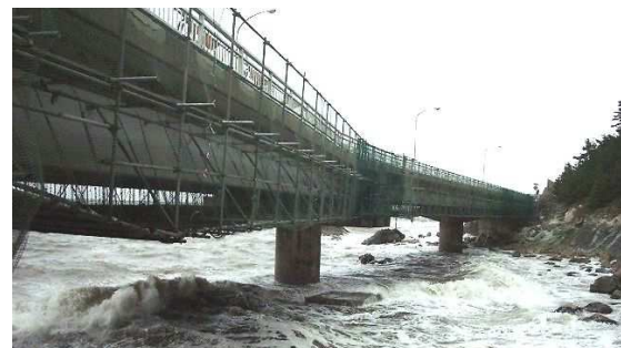
写真 1.1.7 吊り足場による補修状況
