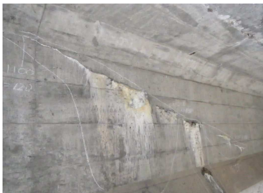
写真 1.1.8 鋼材位置のひび割れ (S46 施工) 写真 1.1.9 高欄のたわみ変状 (S45 年施工)
