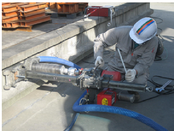
写真 2.3.1 コア削孔の状況
