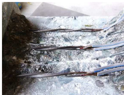
写真 3.3.2 P C 切断後の状況
