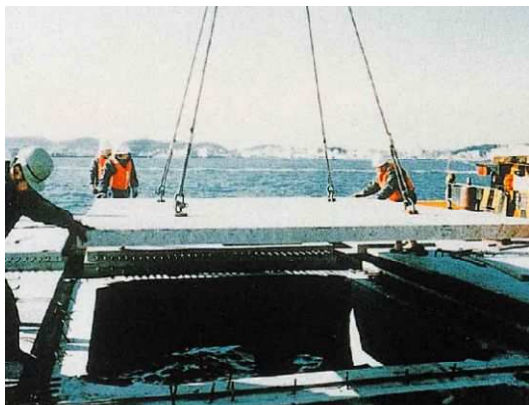
写真 4.1.1 2方向PC栈橋床版
