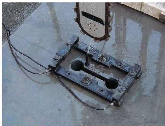
写真 1.2.4 溝の切削完了
