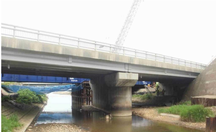
写真 5.1.1 対象橋梁の全景（上流側より撮影）
