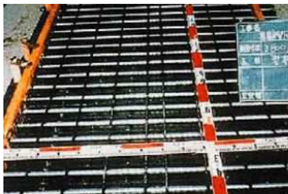
写真 4.1.2 2方向PCの配置状況
