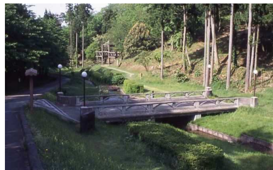
写真1.1.3 長生橋の現状
