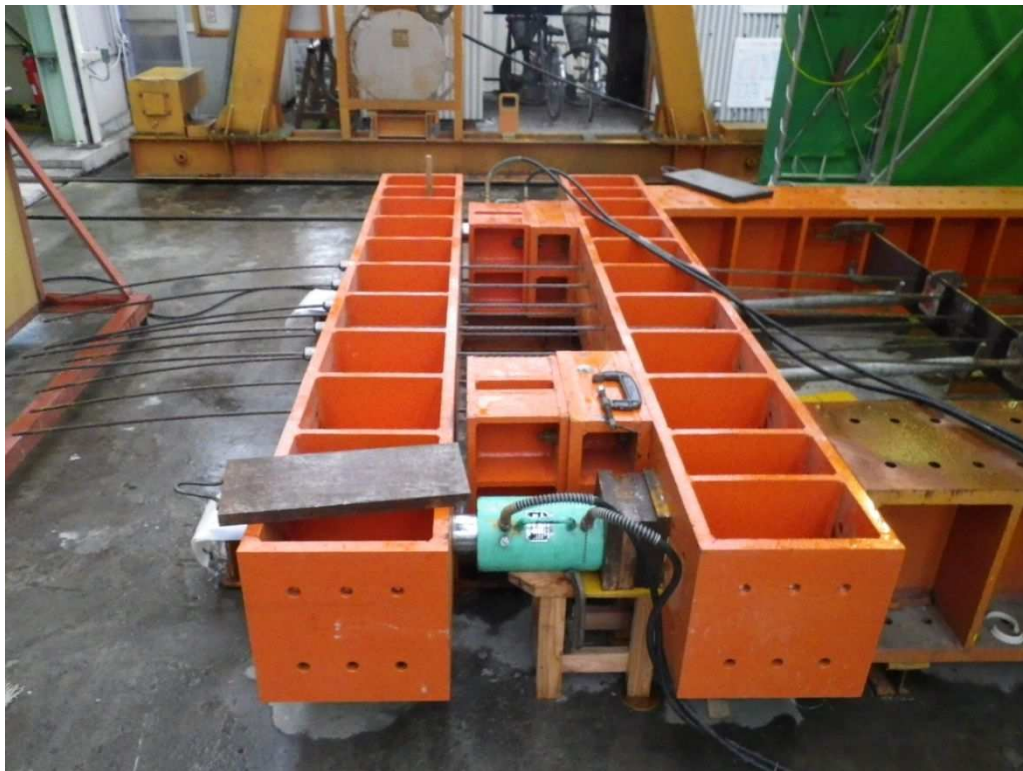
写真 4. 3. 4 打設後ジャッキダウンによるプレ導入
