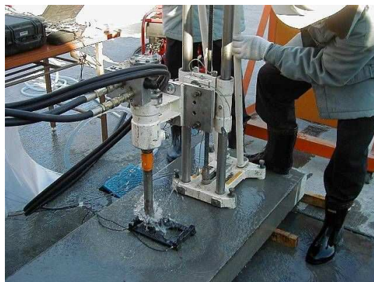
写真 1.2.2 コアの削孔状況
