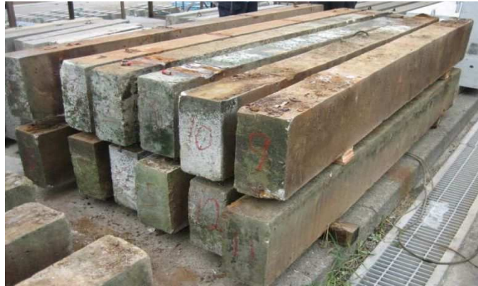
写真 3.3.1 40 年海水暴露供試体
