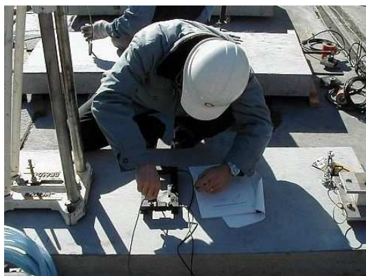
写真 1.2.1 変位計の取付けおよび調整
