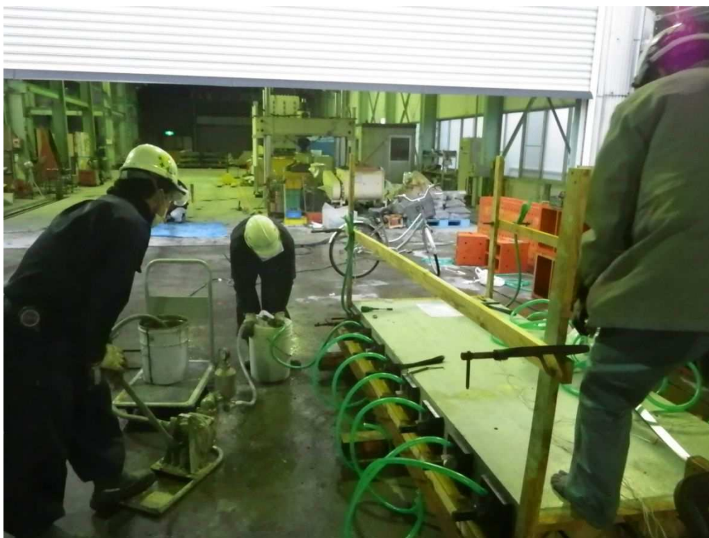
写真 4. 3. 6 ポストテンション鋼材のグラウト注入
