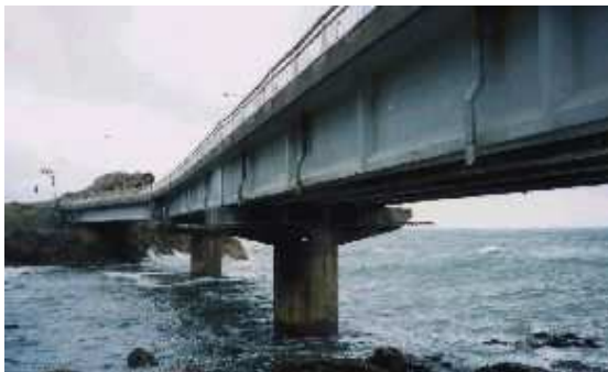
写真 1.1.4 獅子ヶ鼻大橋 (S49 施工)
