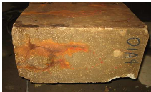
写真 3.3.3 ポストテンション供試体の端部腐食
