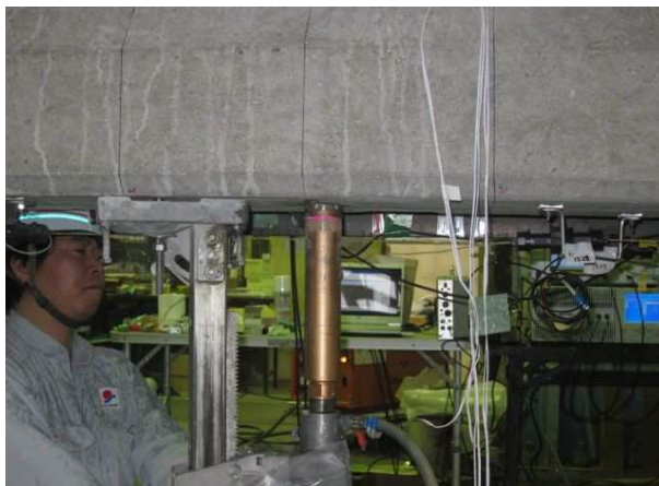
写真 2. 2. 3 コア切込み状況
