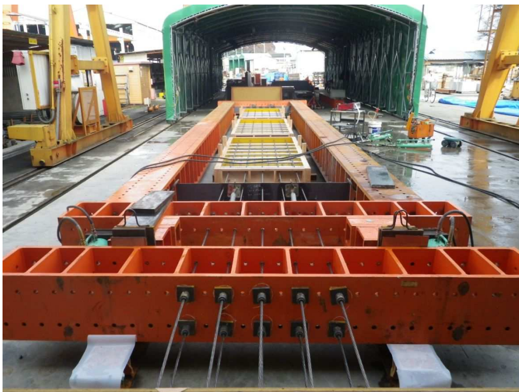
写真 4. 3. 2 プレテンション鋼材の仮緊張
