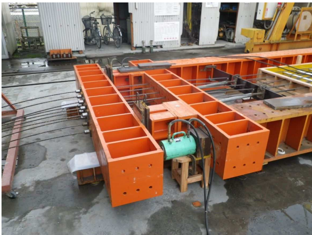
写真 4. 3. 3 プレテンション鋼材の緊張
