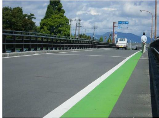
写真 1.1.9 高欄のたわみ変状 (S45 年施工)
