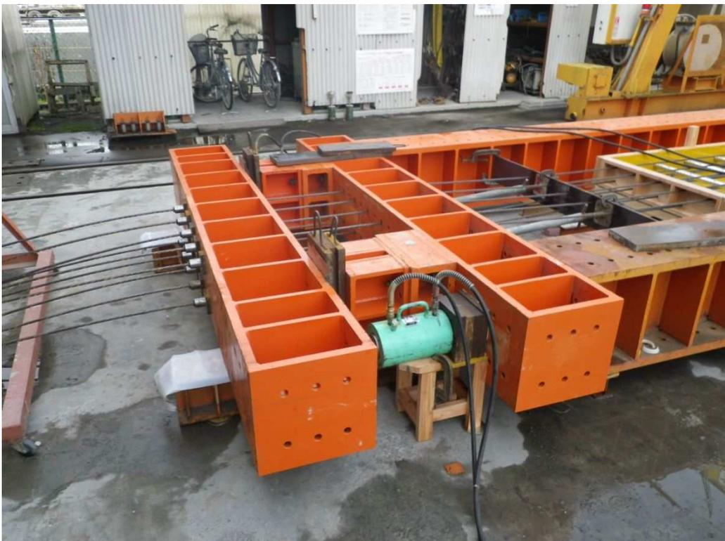
写真 4.3.3 プレテンション鋼材の緊張
