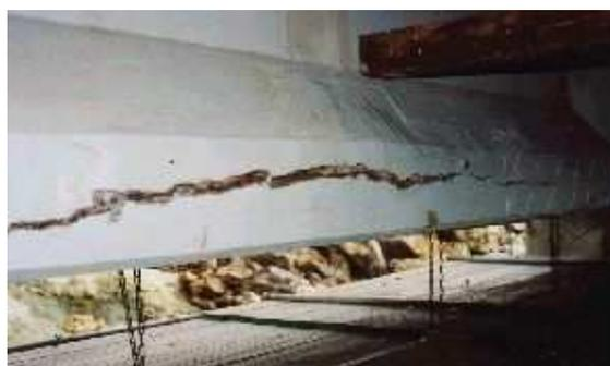
写真 1.1.5 フランジ側面の腐食ひび割れ
