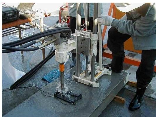
写真 1.2.2 コアの削孔状況
