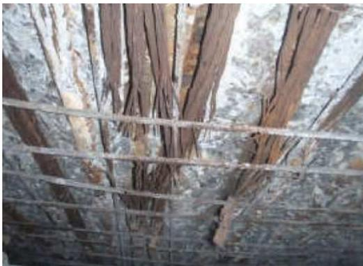
写真 1.1.10 妙高大橋の鋼材破断<sup>4)</sup>
