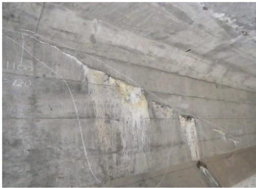
写真 1.1.8 鋼材位置のひび割れ (S46 施工)
