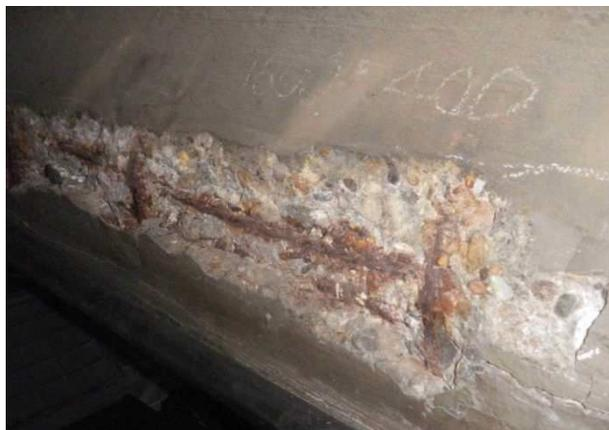
写真 5.1.2 かぶりコンクリートの剥離状況
