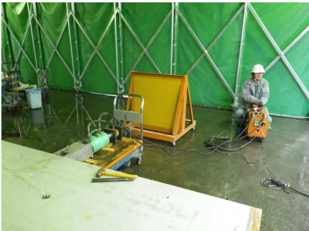
写真 4. 3. 5 ポストテンション鋼材の緊張
