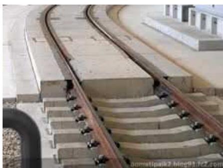
写真1.1.1 PCマクラギ(例)
