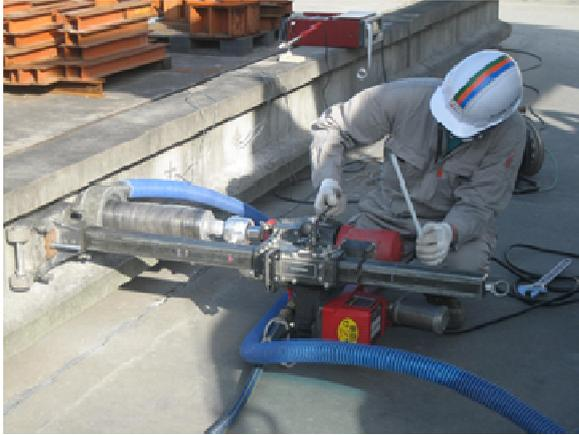
写真 2.3.1 コア削孔の状況
