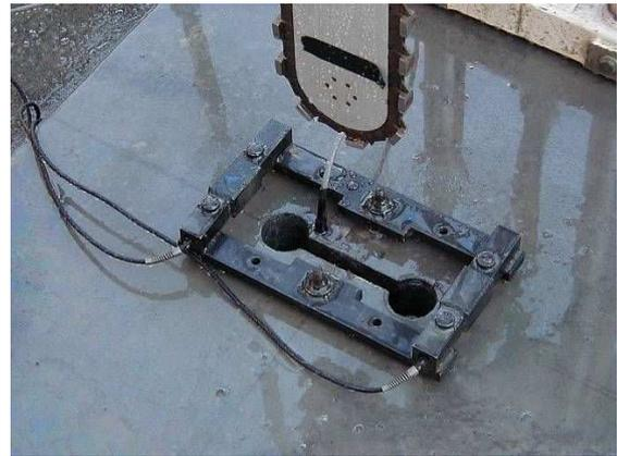
写真 1.2.4 溝の切削完了
