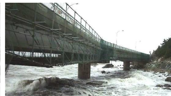
写真 1.1.7 吊り足場による補修状況
