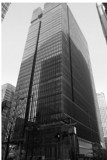
図 7.12 建物O外観
