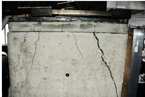
(b) RC 部ひび割れの様子 (150kN 加力時)
