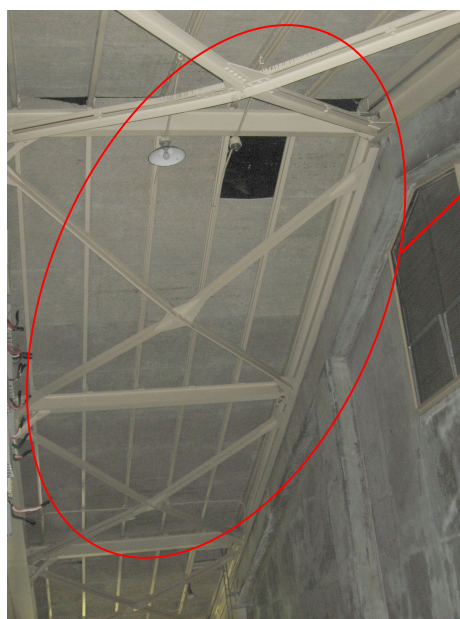
写真2.4 J通り屋根ブレース座屈
