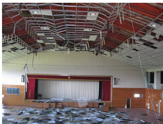
写真2.6 システム天井落下
