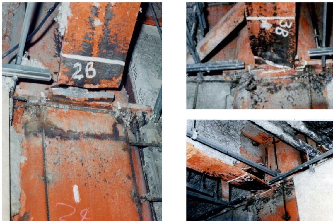
写真1.1 梁端下フランジの脆性破断
