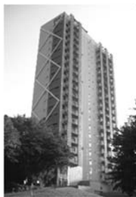
図1 J2棟の外観
