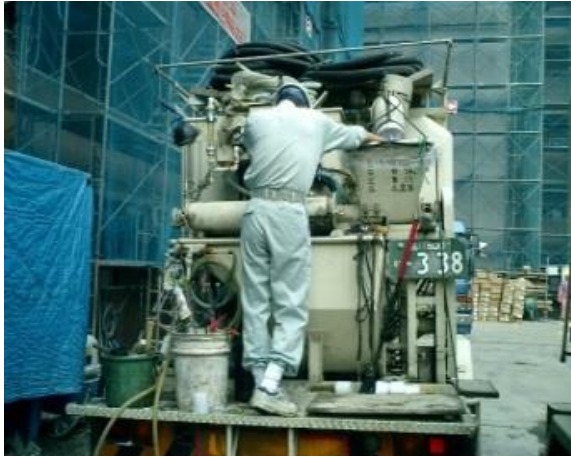
Fig.5-20 ミキサー車を用いた混練の開始
