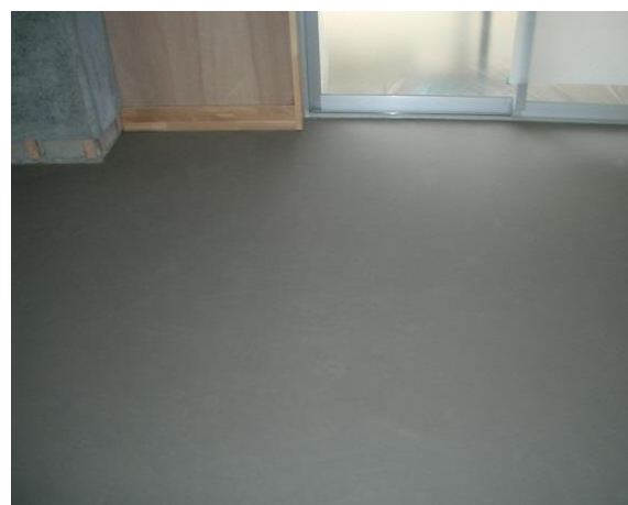
Fig.5-25 セルフレベリング材硬化後の様子
