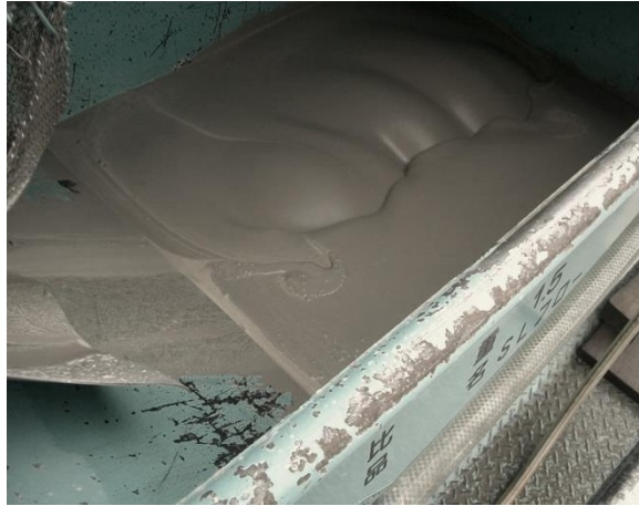
Fig.5-21 セルフレベリング材混練の様子
