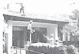
旧食堂解体現場
