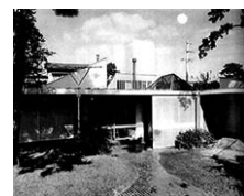
コートハウスの増改築
