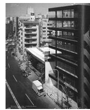
キラールビル
