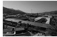
高野口小学校校舎改修・改築
