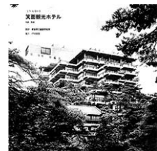
箕面観光ホテル
