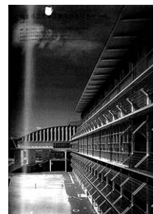
熊本県立天草工業高等学校 実習棟・体育館
