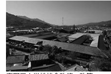
高野口小学校校舎改修・改築
