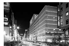
松屋銀座 耐震外装
