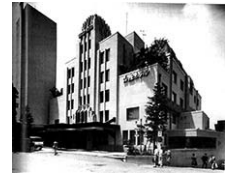
山の上の标本館改修
