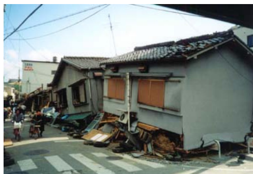
写真1.1 接道面に開口を大きく取った木造住宅の被害 1) (1995年兵庫県南部地震)
