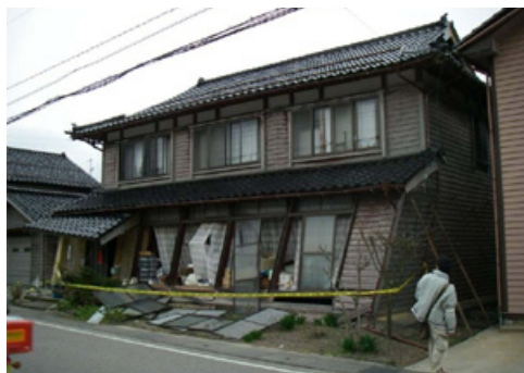
写真 1.5 接道面に大きく開口を取った木造住宅の被害 4) (2007年能登半島地震)
