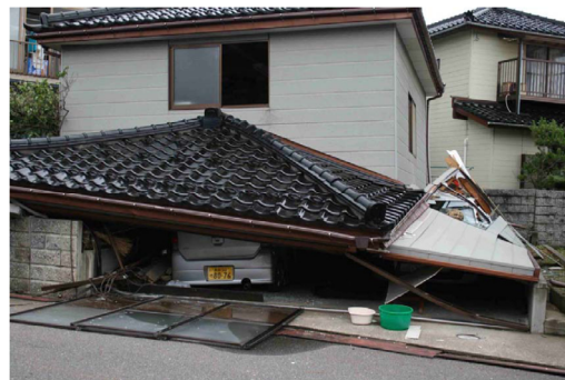
写真 1.8 1階にガレージを持つ木造住宅の被害 6) (2007年新潟県中越沖地震)
