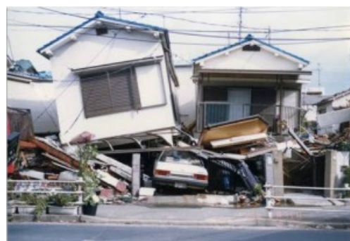
写真1.2 1階にガレージを持つ木造住宅の被害 2) (1995年兵庫県南部地震)
