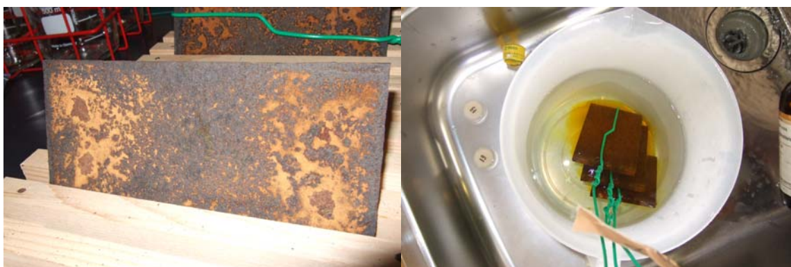
(1) 屋外に放置された鋼材の錆
