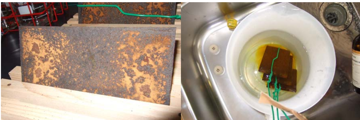
(1) 屋外に放置された鋼材の錆
