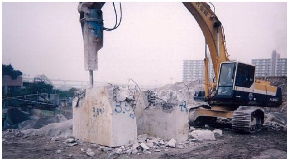
写真 5.1(1) 再生骨材製造工場での重機による破砕
