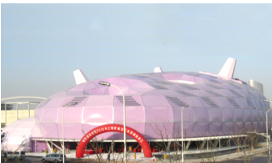
(h) 上海万博日本館ドーム
