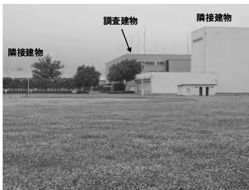
写真 1-1 劣化状態調査建物の概要
