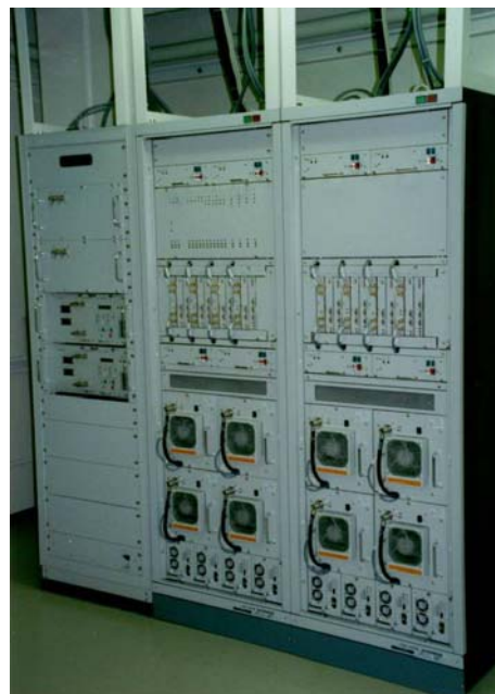
図 3-33 今回実用化した ARIB STD-39 準拠無線基地局装置 架の大きさ（たて、横、高さ）600 × 650 × 1800 (mm) 消費電力（電力増幅器の RF 出力） 1450W（最大実装時/1
