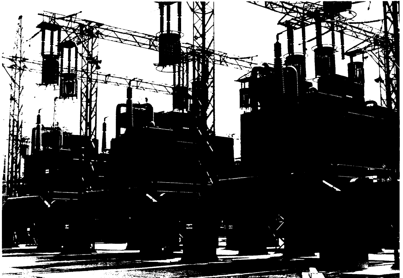
図1-3 油冷バルブ現地据付状況
