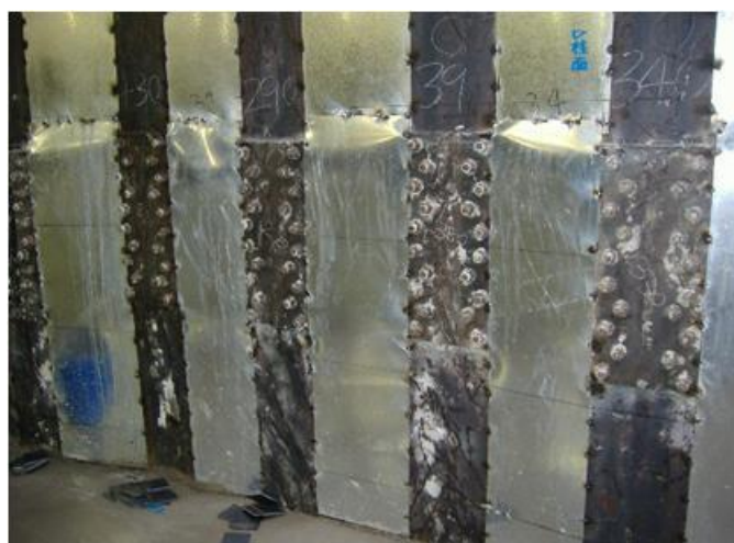
写真 3.5 芯材H鋼のジョイントボルト
