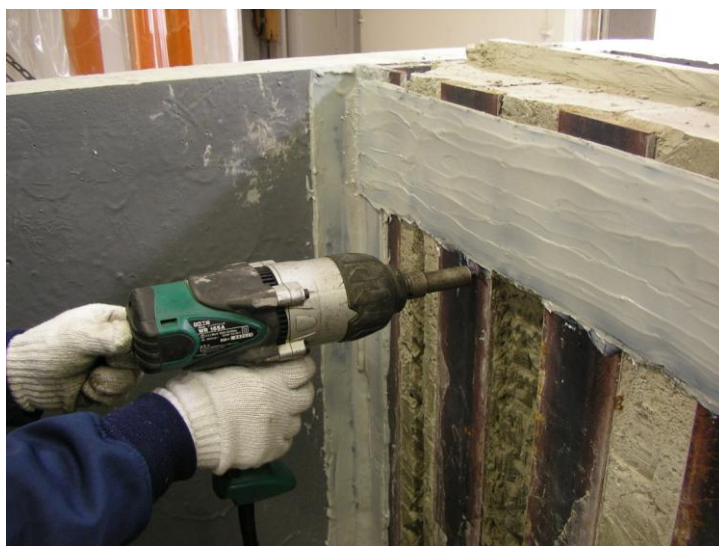
写真 4.3 セパレータ受け金物設置
