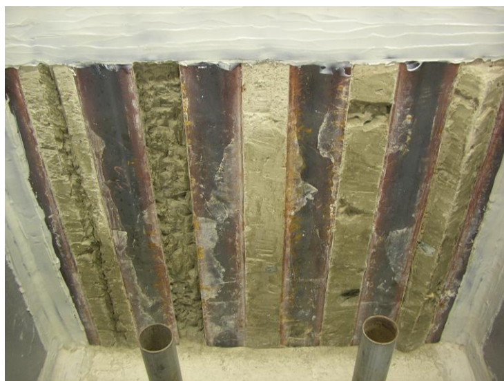
写真4.2 ソイルセメント山留め壁
