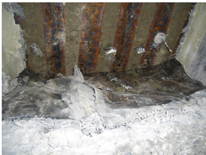
写真 4.17 シート防水層裏面
