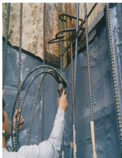
写真 3.13 鉄筋工事先行
