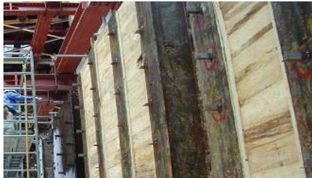
横アンゲルを通してセパレーターを固定する山留の場合、横アンゲルを通す前の、アンゲルピース(ネコアンゲル)だけの状態で、先やり防水を施工する。
