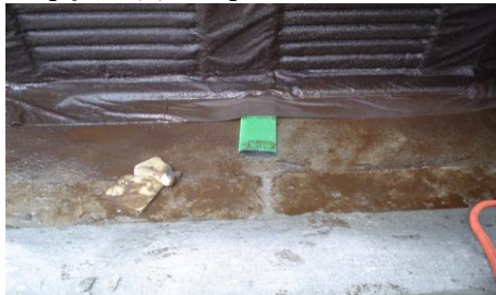
【均しコンクリート上】
