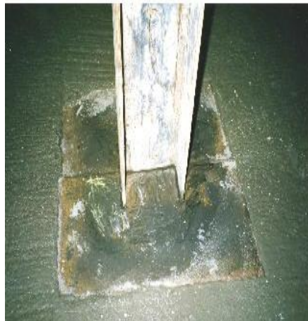
H鋼の付着物除去に時間と労力を要する
