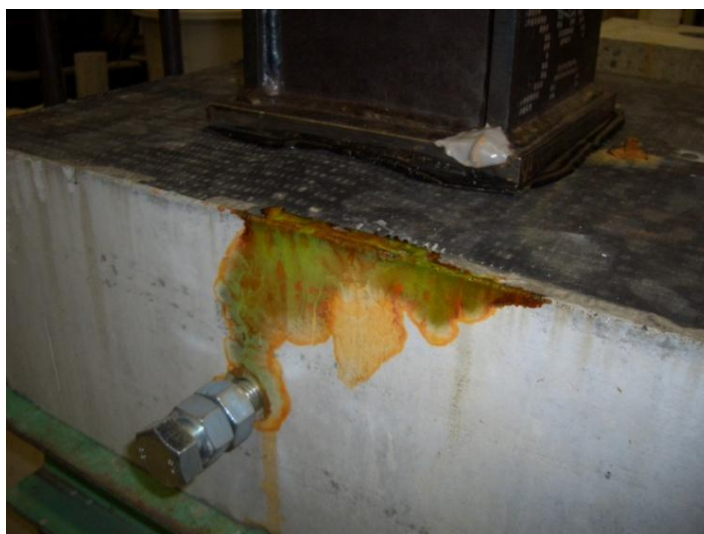
写真 5.6 側面からの漏水状況（鉛直打設）
