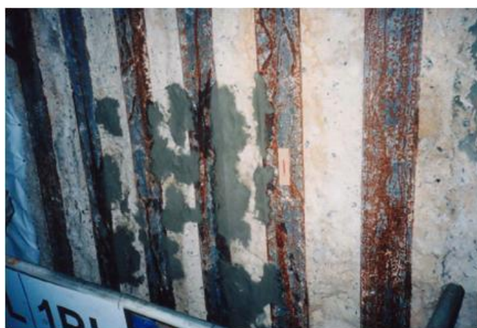
写真 3.3 モルタルによる凹凸補修
