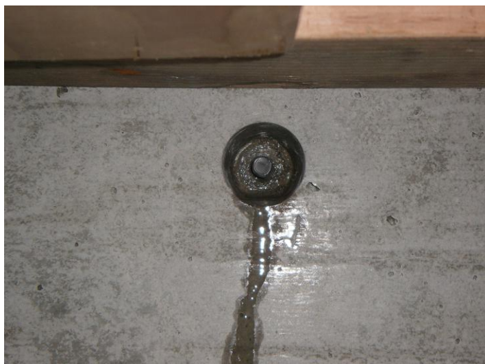
写真 4.11 タイプAセパレータ 染み出し (塗膜系)
