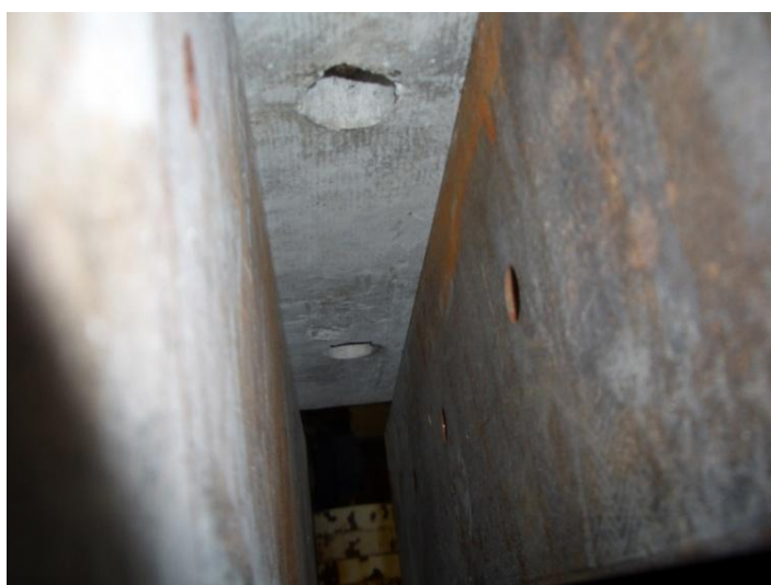
写真 5.5 試験体裏面（鉛直打設）
