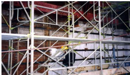
(非常に良くない事例だが)このように横アンゲルを既に通してしまった山留に対し、先やり防水を施工し
