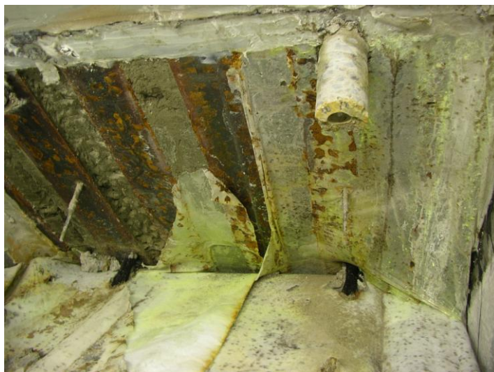
写真 4.16 塗膜防水層裏面
