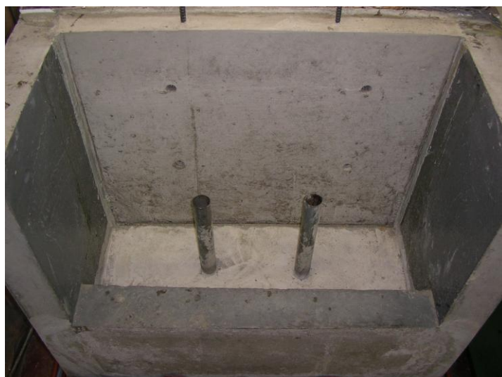
写真 4.8 躯体コンクリート 打設後
