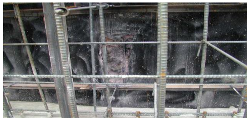
溶接作業でバーナーにより焼かれ、
