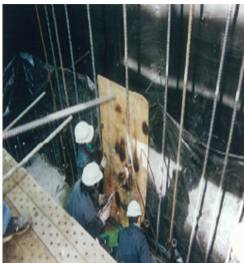
写真 3.29 溶接時の合板養生例
