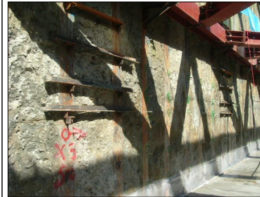
親杭との間に隙間を作らずにベタに溶接されたアングル
