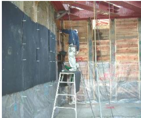
薄い防湿シートの引き込み
