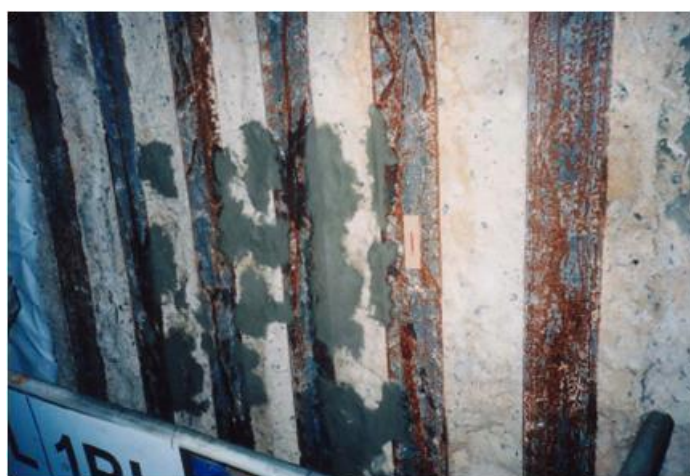
写真 3.3 モルタルによる凹凸補修
