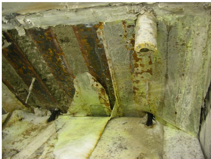
写真 4.16 塗膜防水層裏面
