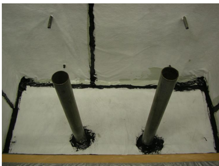
写真 4.4 導水層設置 底盤貫通パイプ処理
