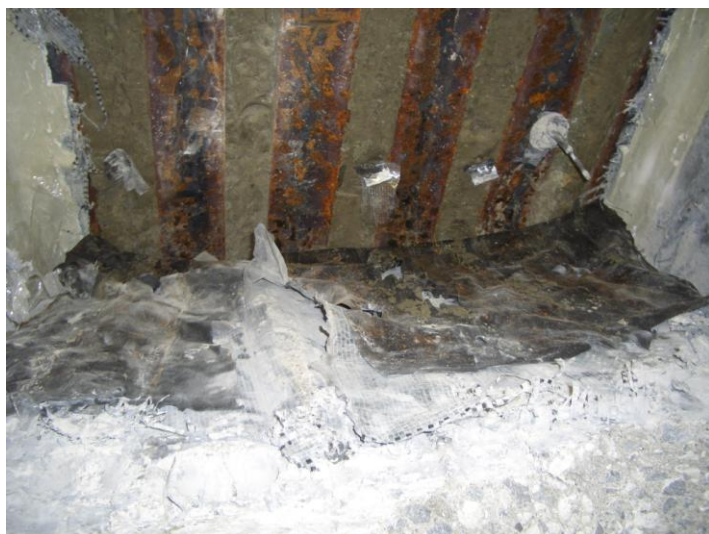
写真 4.17 シート防水層裏面
