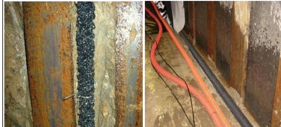
底版部の入隅部に沿って排水材設置
