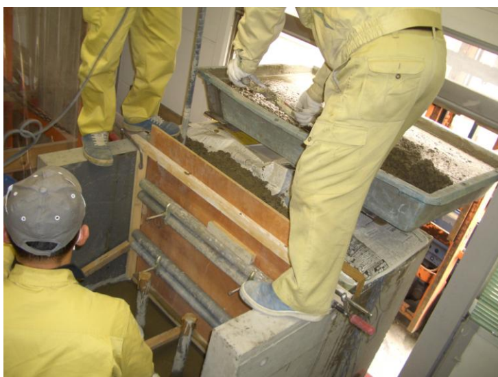
写真 4.7 コンクリート打設
