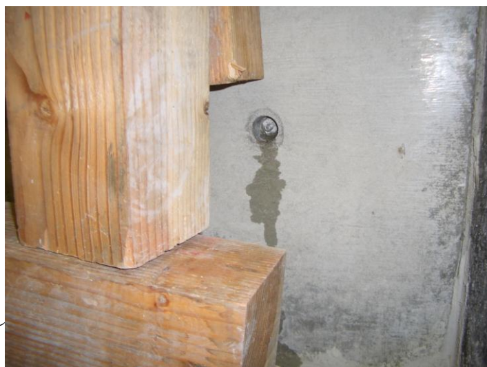
写真 4.14 下段セパレータ染出し (シート系)
