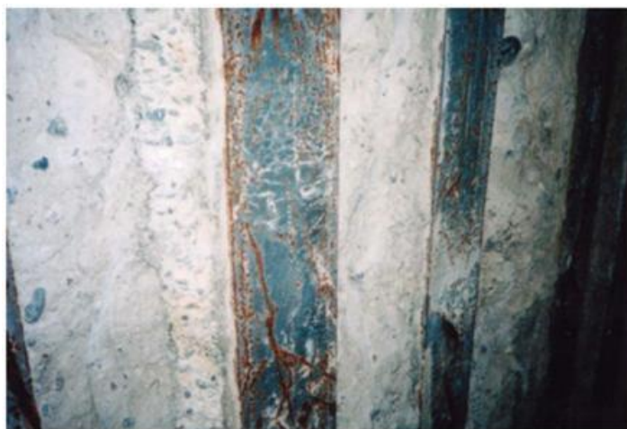
写真 3.2 ソイルセメント面の凹凸
