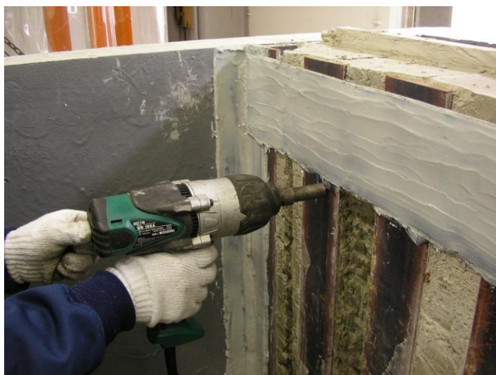
写真 4.3 セパレータ受け金物設置
