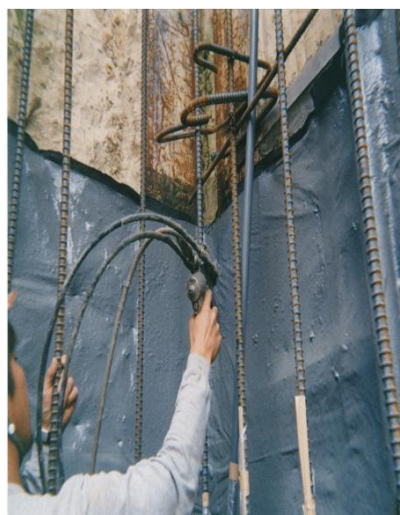
写真 3.13 鉄筋工事先行
