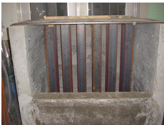
写真4.1 SMW山留め壁芯材H型鋼
