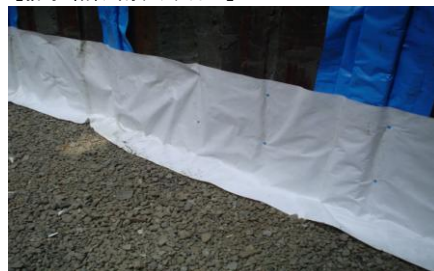
【排水暗渠・割りぐり石上】
