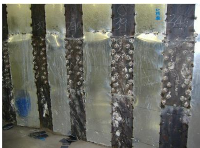
写真 3.5 芯材H鋼のジョイントボルト
