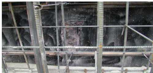
溶接作業でバーナーにより焼かれ、
