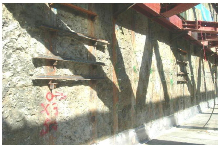
写真 3.14 セパレータ受けアングル溶接先行
