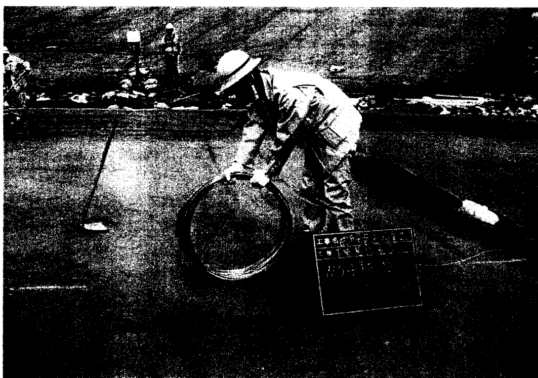
写真-5.6 遮水シート下の線電極の設置 ( \phi 5mm 裸銅線)
