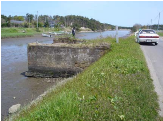
図 5.2 上の橋のレンガ製橋脚
