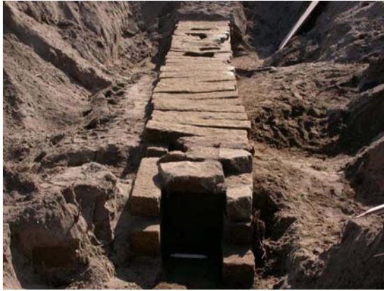
図 5.1 悪水吐暗渠跡とそこに使用された近代土管接合部のセメント様硬化体 1,2,3)
