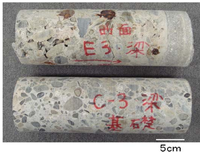
図 6.17 採取されたコンクリートコアの外観
