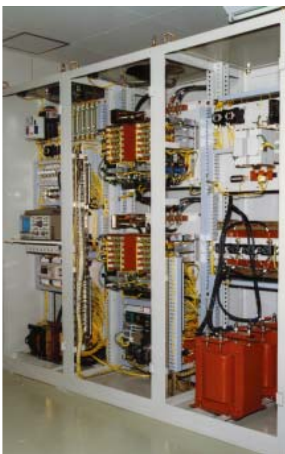
図3-2-16 電源障害試験装置内部
