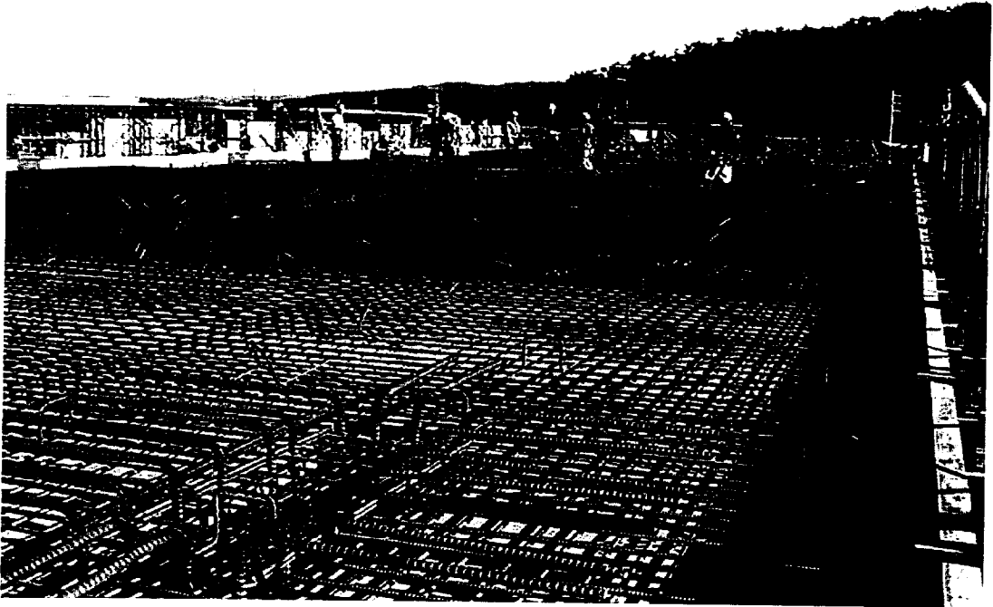
写真A2 PRC造フラットスラブのPC鋼線と鉄筋の配置状況
