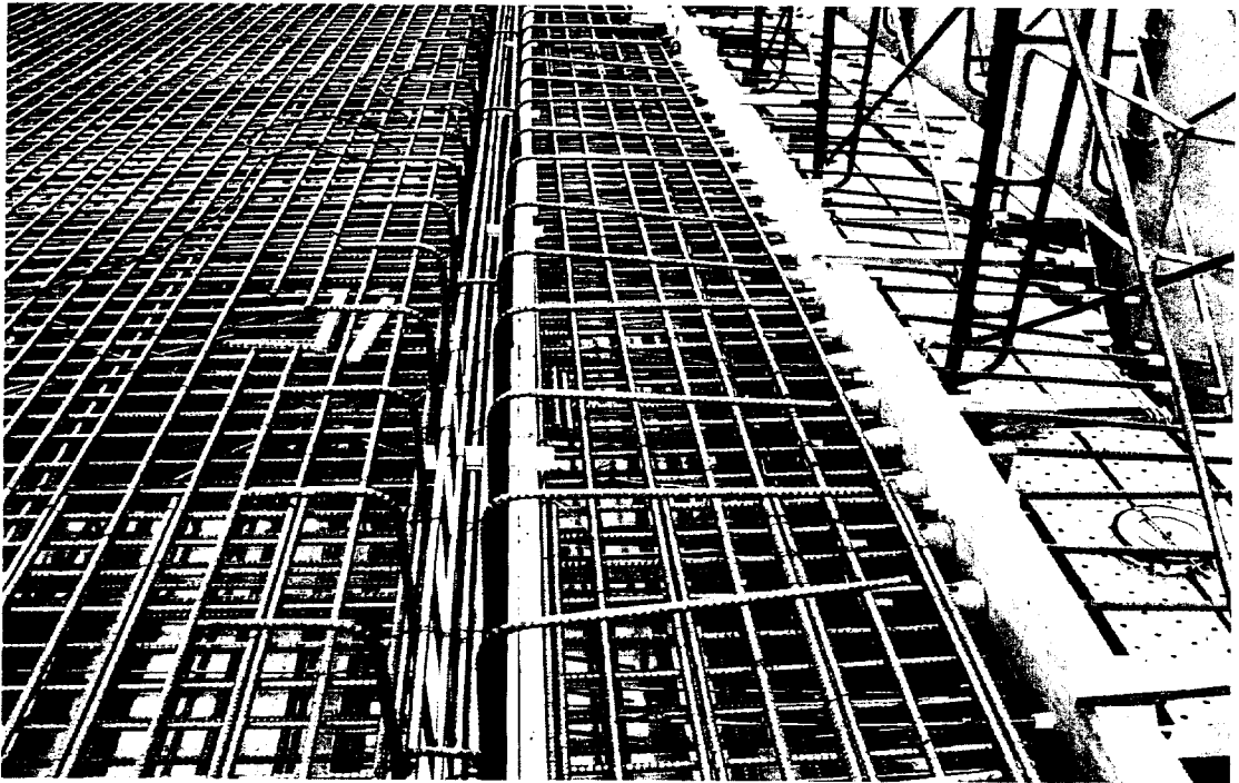
写真A4 PRC造フラットスラブの端部のPC鋼線定着状況
