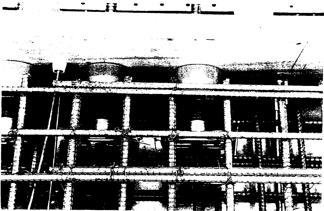
写真A3 PC鋼線の定着部の納まり
