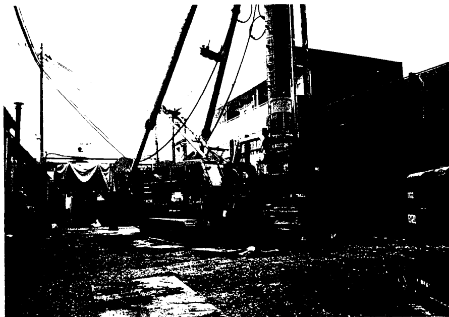
写真-4.4.1 2軸回転翼D J M機
