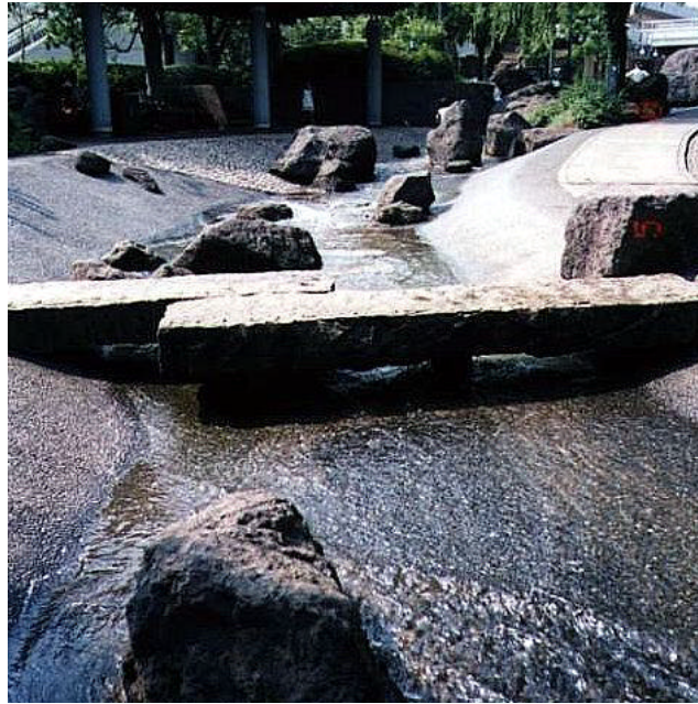
図 - 3.6 流れにかかる橋 エリア2のパーゴラ下に橋が架かっていて、兩岸を結んでいる。 ここは、住民の通路として通過利用されているほか、 水景施設で水遊びする子供が流れ（水深は5 [cm]以下）に平行にまたぐ姿が見られる。 なお、水面と橋の下面との間隔が低いため橋の下をくぐることはできない。
