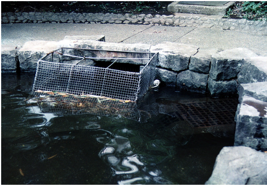
図 - 3.8 取水口と排水口
