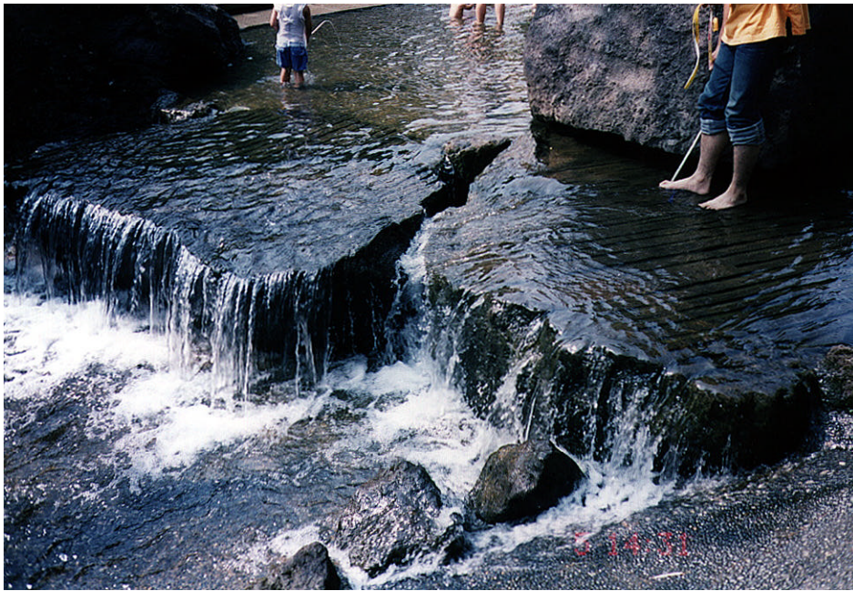
図 - 3.4 上部の池と流れを結ぶ滝 上部の池にたまっている水は、ここから流れに落ち込む。 レベル差は70[cm]あるので、子供が直接ここをまたぐことはむずかしい。 また、この付近の床面は玉石仕上げのため比較的すべりやすい。
