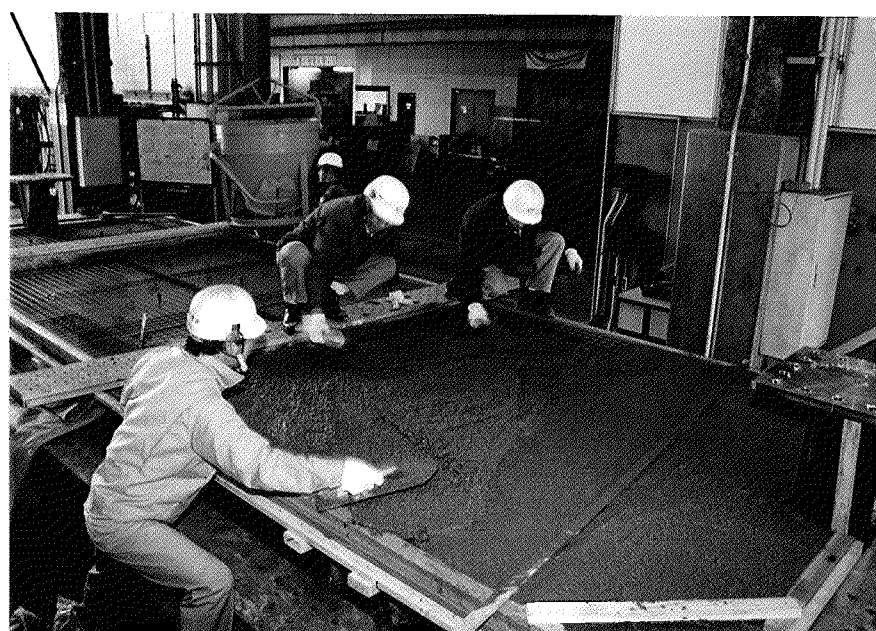
写真 A-3 (2) スラブのコンクリート打設
