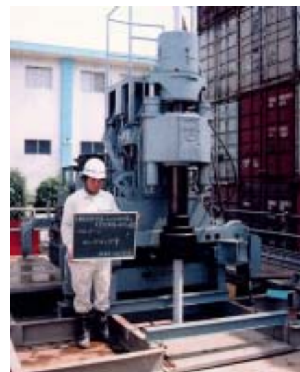
写真2.1.6 サンプリングマシンによる削孔
