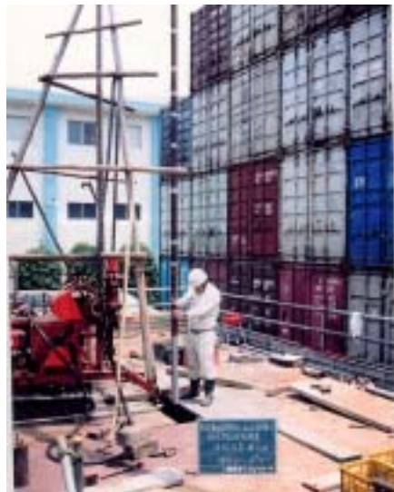
写真2.1.3 凍結外管設置
