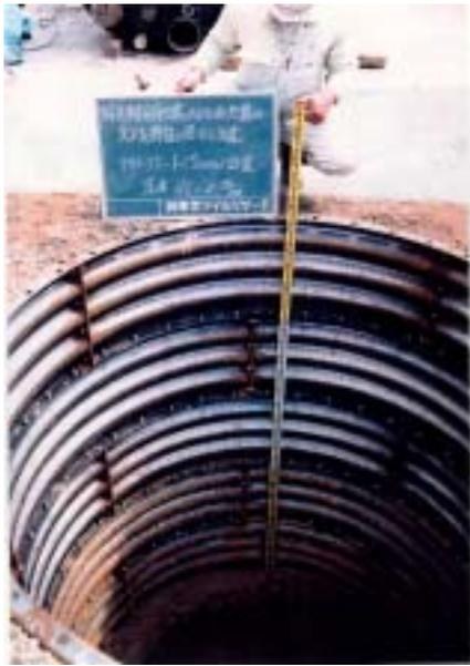
写真 2.1.1 掘削孔の孔壁保護
