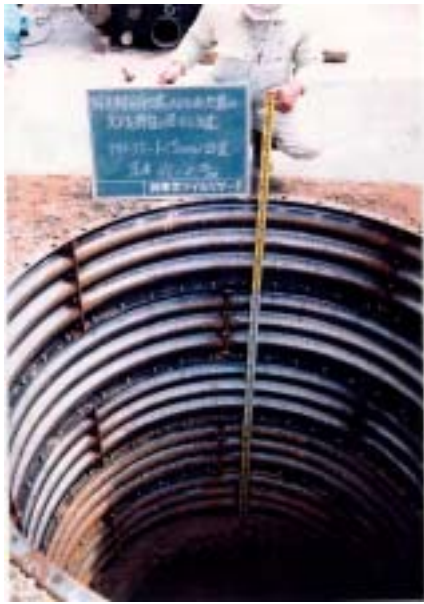
写真 2.1.1 掘削孔の孔壁保護
