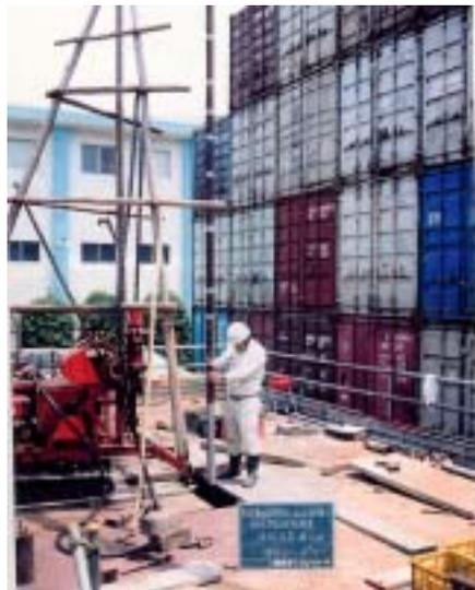
写真2.1.3 凍結外管設置
