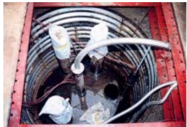
写真2.1.4 地盤凍結前の状況
