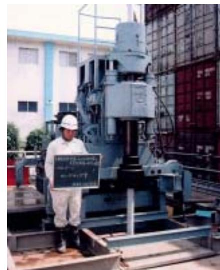
写真2.1.6 サンプリングマシンによる削孔
