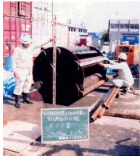
写真 2.1.2 サンプリング用ガイド管
