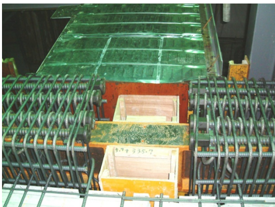
境界梁ダンパー根巻き部配筋
