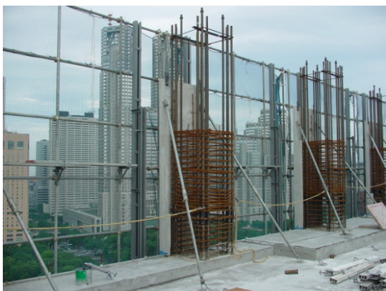
柱の配筋状況
