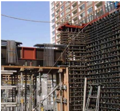
境界梁ダンパー周辺の配筋状況
