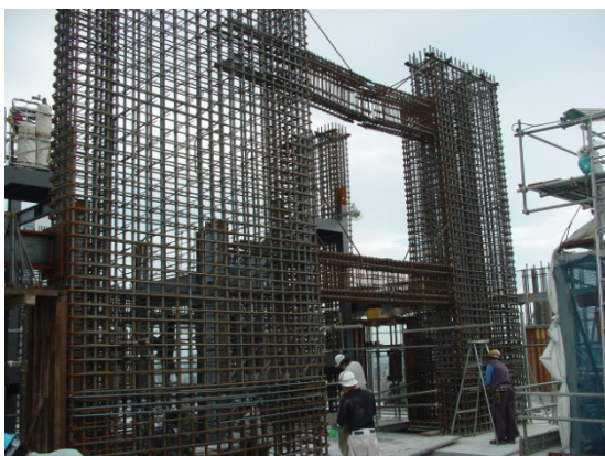
耐震壁の配筋状況
