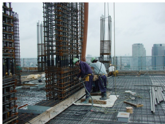
耐震壁のコンクリート打設
