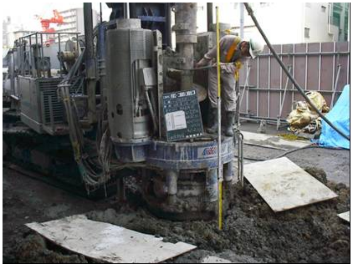
図-6.2 先行削孔状況
