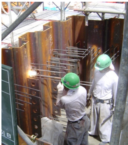
(b) 鉄筋スタッド溶接
