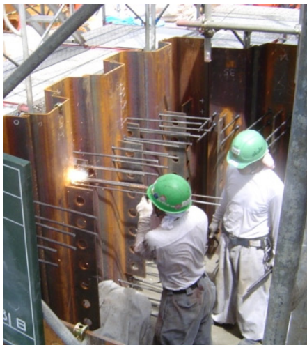
(b) 鉄筋スタッド溶接
