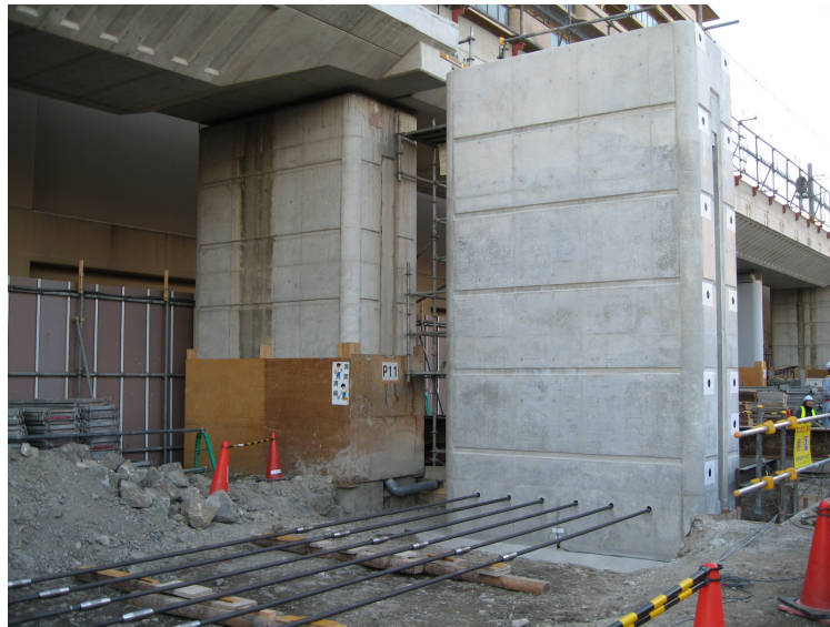
図-6.5 試験対象橋脚
