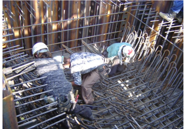
(c) フーチング鉄筋組み立て
