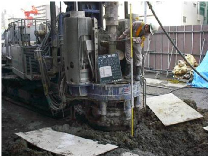
図-6.2 先行削孔状況
