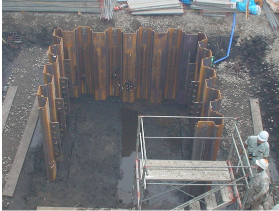
(a) シートパイルの打設
