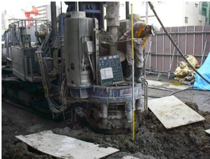
図-6.2 先行削孔状況
