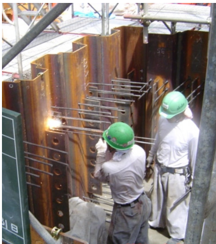
(b) 鉄筋スタッド溶接
