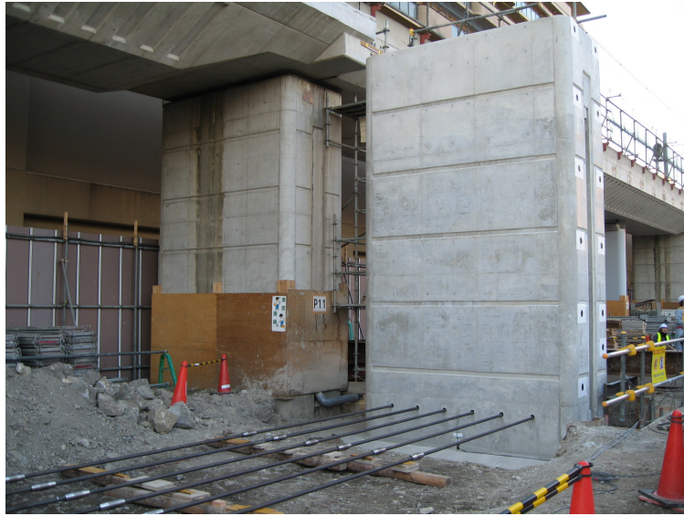
図-6.5 試験対象橋脚
