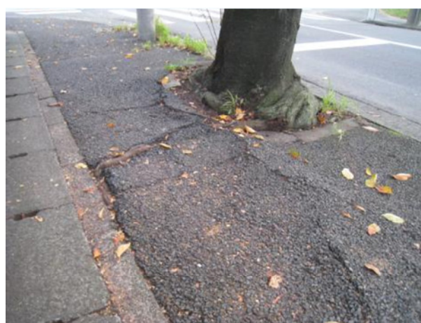
写真1.1 根による歩道舗装の損傷事例
