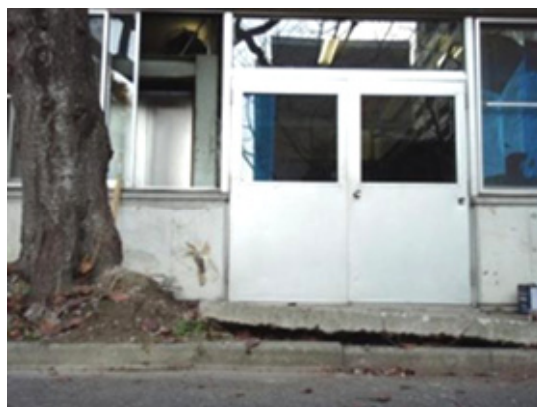
写真2.4 コンクリート板の持ち上げ
