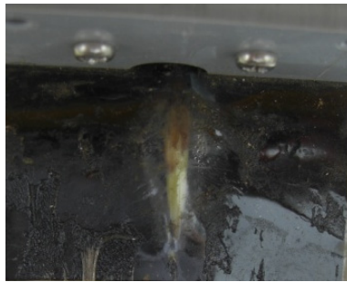
写真5.9 シート防水ジョイント部の剥離状況(両面接着シートによる接着)1/2
