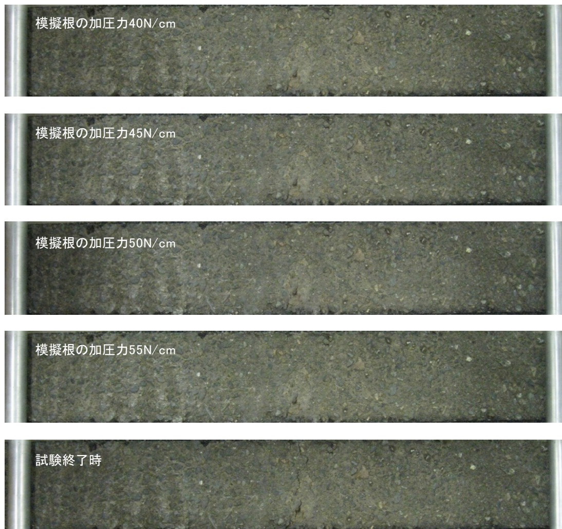
写真3.13 アスファルト舗装表面のひび割れ状態の一例(模擬根直上の砂層の厚さ0mm) 2/2
