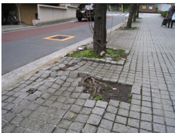
写真1.1 根による歩道舗装の損傷事例
