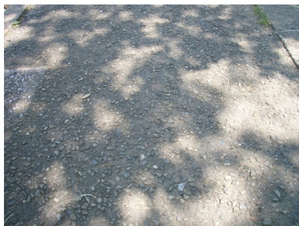
写真3.10 アスファルト舗装の路面の状態
