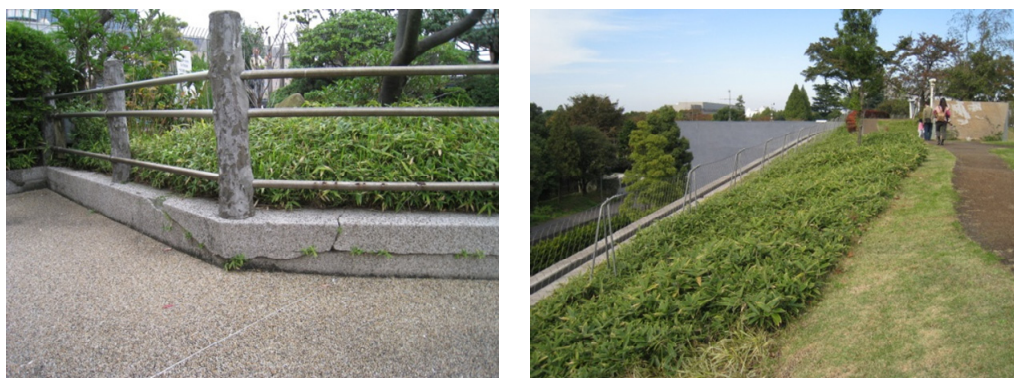
写真4.3 屋上緑化にクマザサが植栽されている事例
