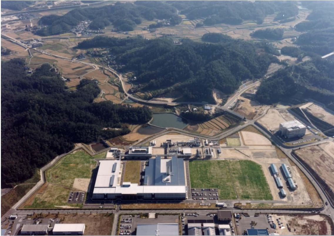
写真 4 - 3 大日本印刷三原工場（1期竣工）
