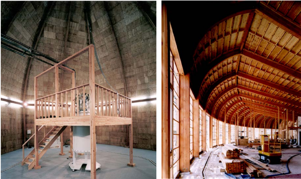
写真1. 6. 3 ライフサイエンス技術基盤研究センター（左：1期 右：2期工事中） [写真提供：理化学研究所]
