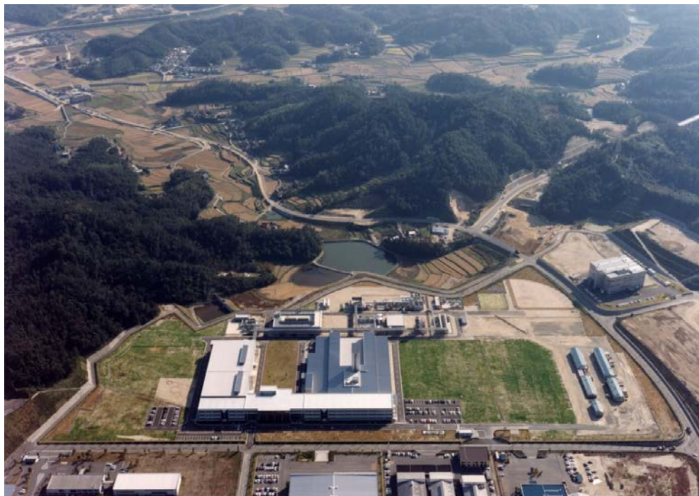
写真 2. 7. 1 大日本印刷三原工場（1期）
