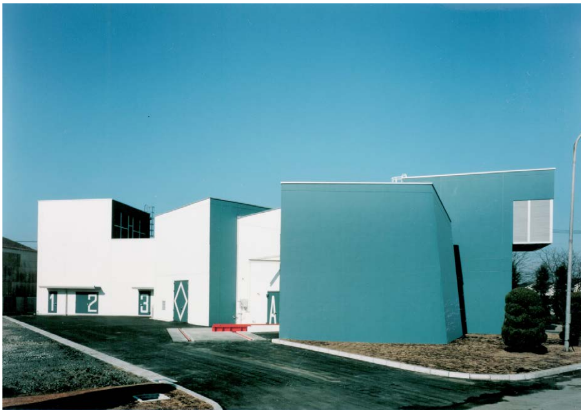
資料 1. 1 2. 1 栗本鐵工所 音響実験棟
