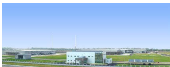
写真2. 14. 3 事務棟・工場（1期竣工）
