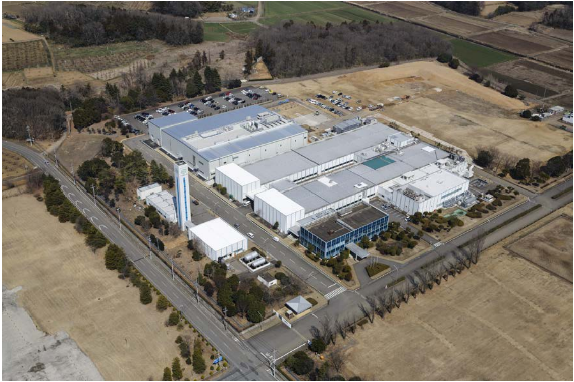
写真5-1 つくば工場全貌 [手前から1号棟、2号棟、3号棟] [写真提供：日本薬品工業株式会社]
