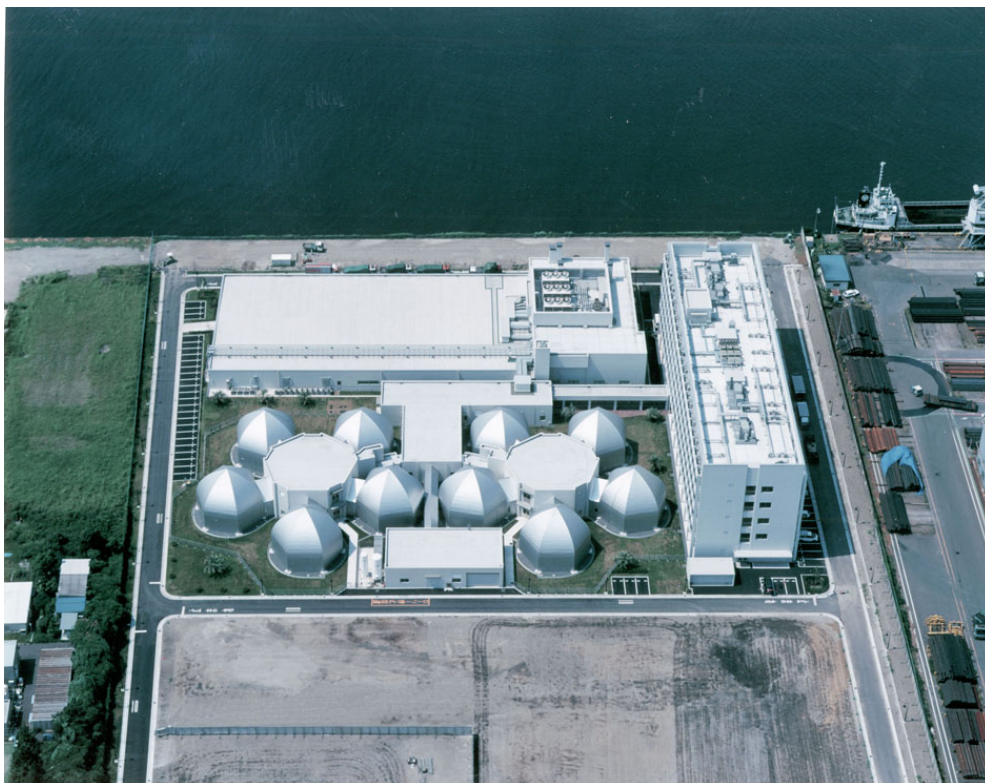
写真 1. 6. 1 ライフサイエンス技術基盤研究センター（1期） [写真提供：理化学研究所]
