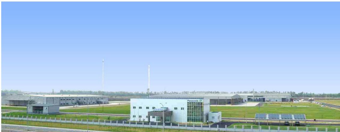
写真4-5 パナソニック・インド・テクノパーク1期竣工 [資料提供：パナソニック株式会社]
