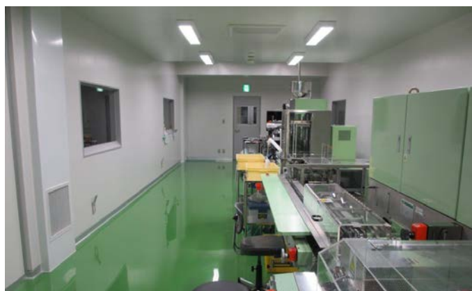
写真 2. 1 2. 2 包装ラインクリーンルーム
