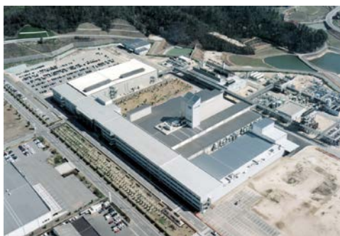
写真 2. 7. 2 大日本印刷三原工場（2期）
