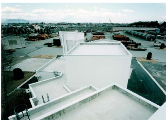
資料 1. 1 2. 2 栗本鐵工所 音響実験棟
