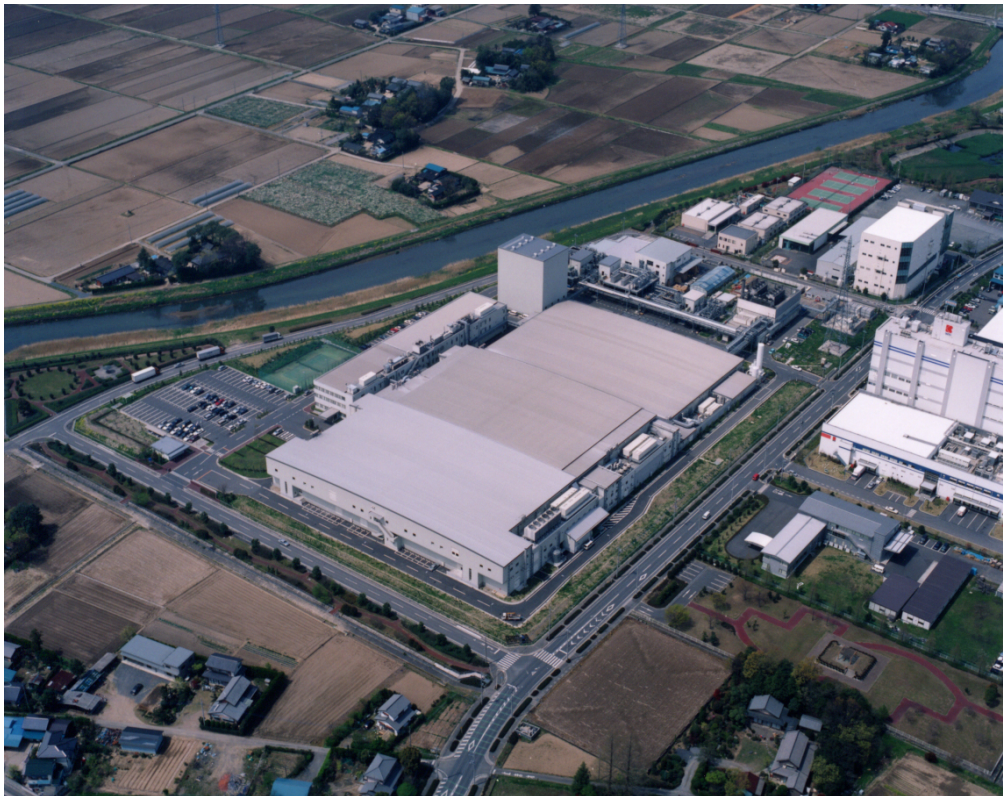
写真4-2 大日本印刷大利根工場3期完成 [写真提供：大日本印刷株式会社]
