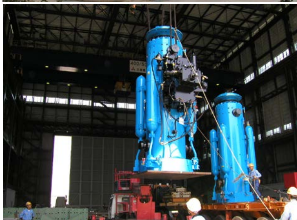
写真 1. 5. 2 上：建設中 下：アクチュエータ
