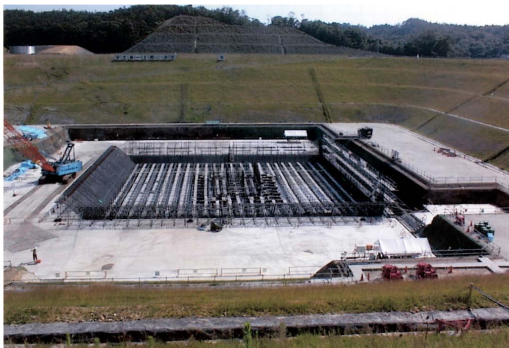
写真3-2 E-ディフェンス基礎工事 [写真提供：防災科学技術研究所]
