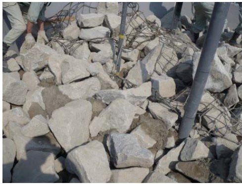
(a) 表面の巨石を撤去した状況
