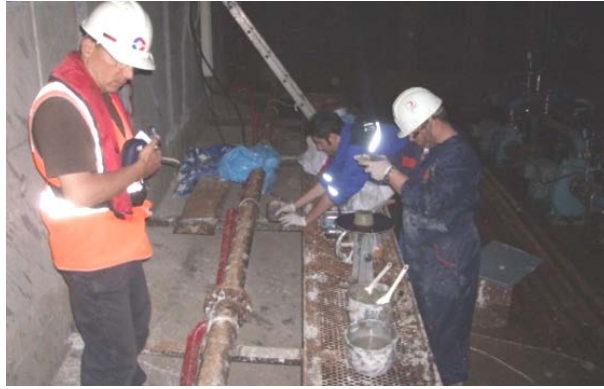
図-5.23 函体内での品質試験状況
