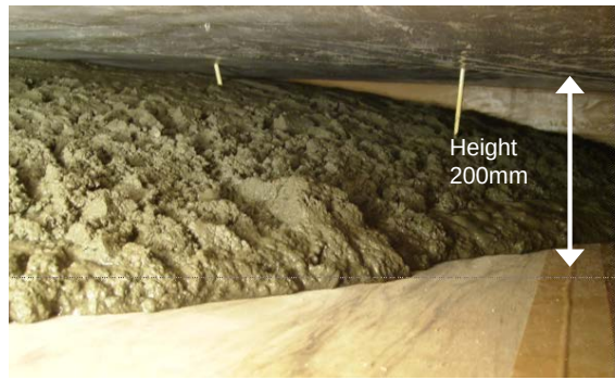
図-3.44 先行充填中の状況
