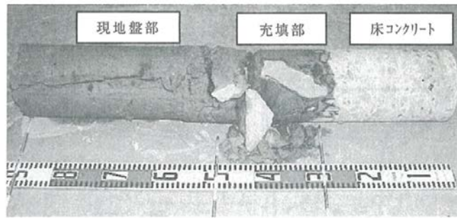
図-2.27 充填完了後のチェックボーリング
