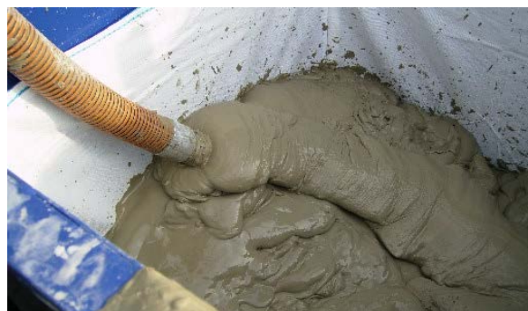
図-2.14 可塑性グラウトの例
