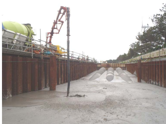
図-6.1 流動化処理土の施工例
