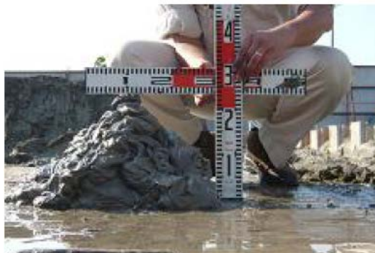
図-2.23 打設形状の確認状況
