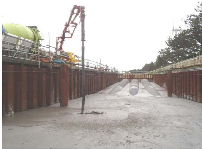
図-6.1 流動化処理土の施工例
