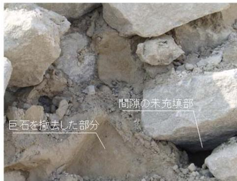
(c) 間隙に残された空洞
