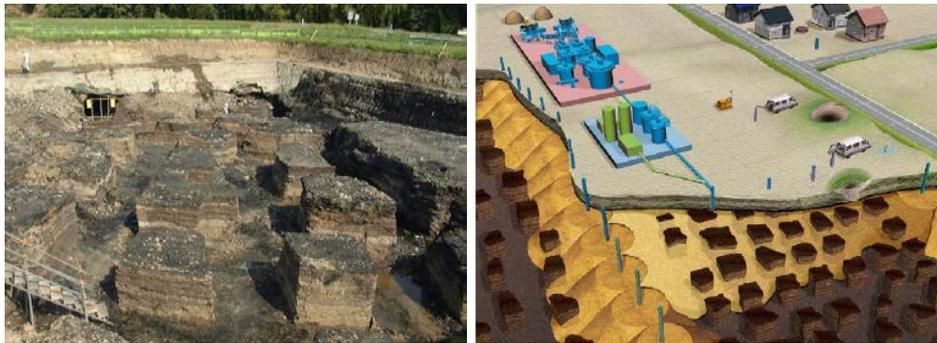
図-2.21 上部層を撤去して露出された亜炭鉱廃坑の例(左)と埋戻し工事のイメージ(右)
