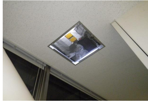
⑨天井復旧, 点検口取付け
