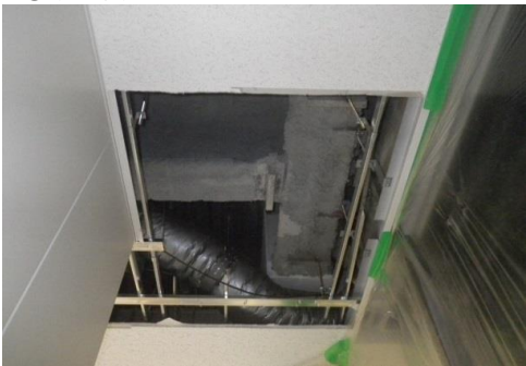
③天井一部撤去
