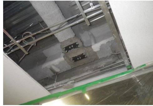
⑥耐火被覆の一部復旧
