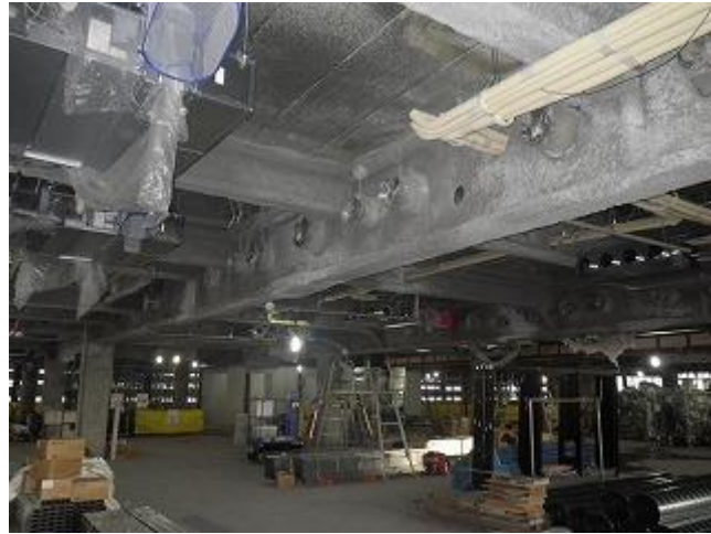
写真 4.3.1 大規模スパン建築物床の概要（大梁）
