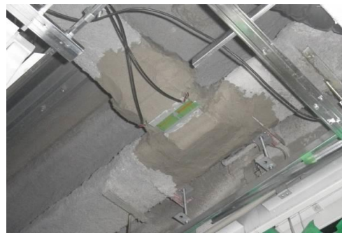
⑧耐火被覆復旧
