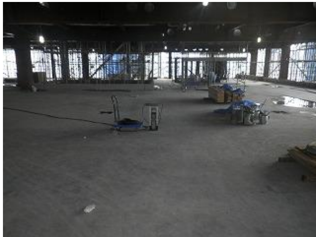
写真 4.3.2 起振器によるアクセラランス測定状況
