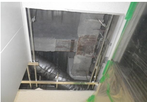
④ 耐火被覆一部撤去
