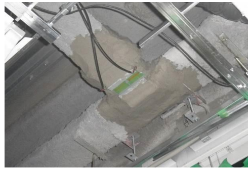
⑧ 耐火被覆復旧
