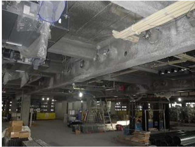
写真 4.3.1 大規模スパン建築物床の概要（大梁）
