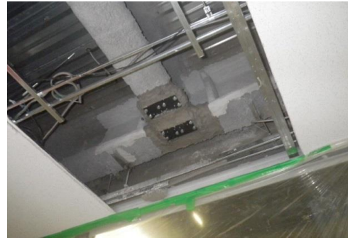
⑥ 耐火被覆の一部復旧
