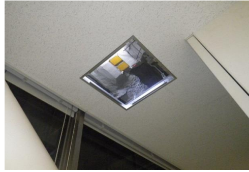
⑨ 天井復旧, 点検口取付け
