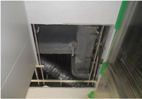
③ 天井一部撤去
