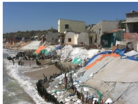
図-1 ファンティエットの海岸侵食状況と人がまだ住む被害住家 (筆者撮影)
