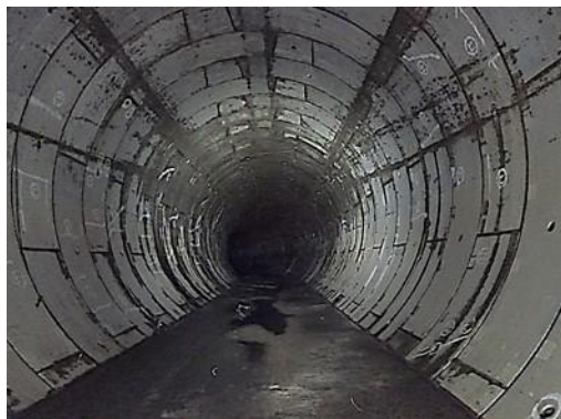
写真 1-9 神田川環状 7 号線地下調整池
